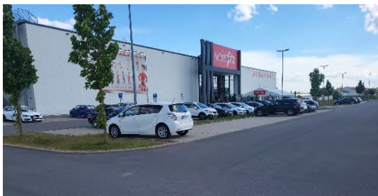
Parkflächen Richtung Westen
